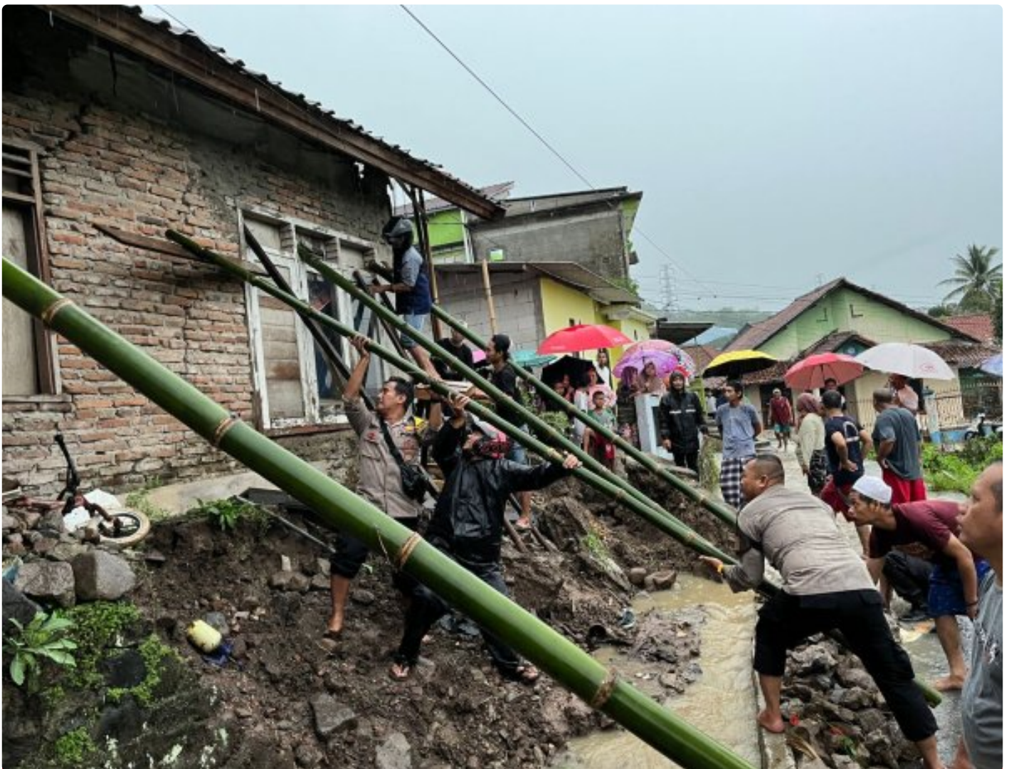
Polisi diPalabuhanratu Bantun Evakuasi Tembok Pagar Ambruk Akibat Hujan Deras, Rumah Warga di Desa Citarik Rusak
