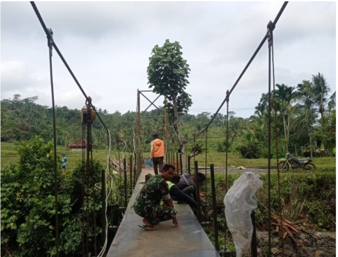
Kpt Arm Witono: Pengerjaan Jembatan Gantung Sudah 80%
