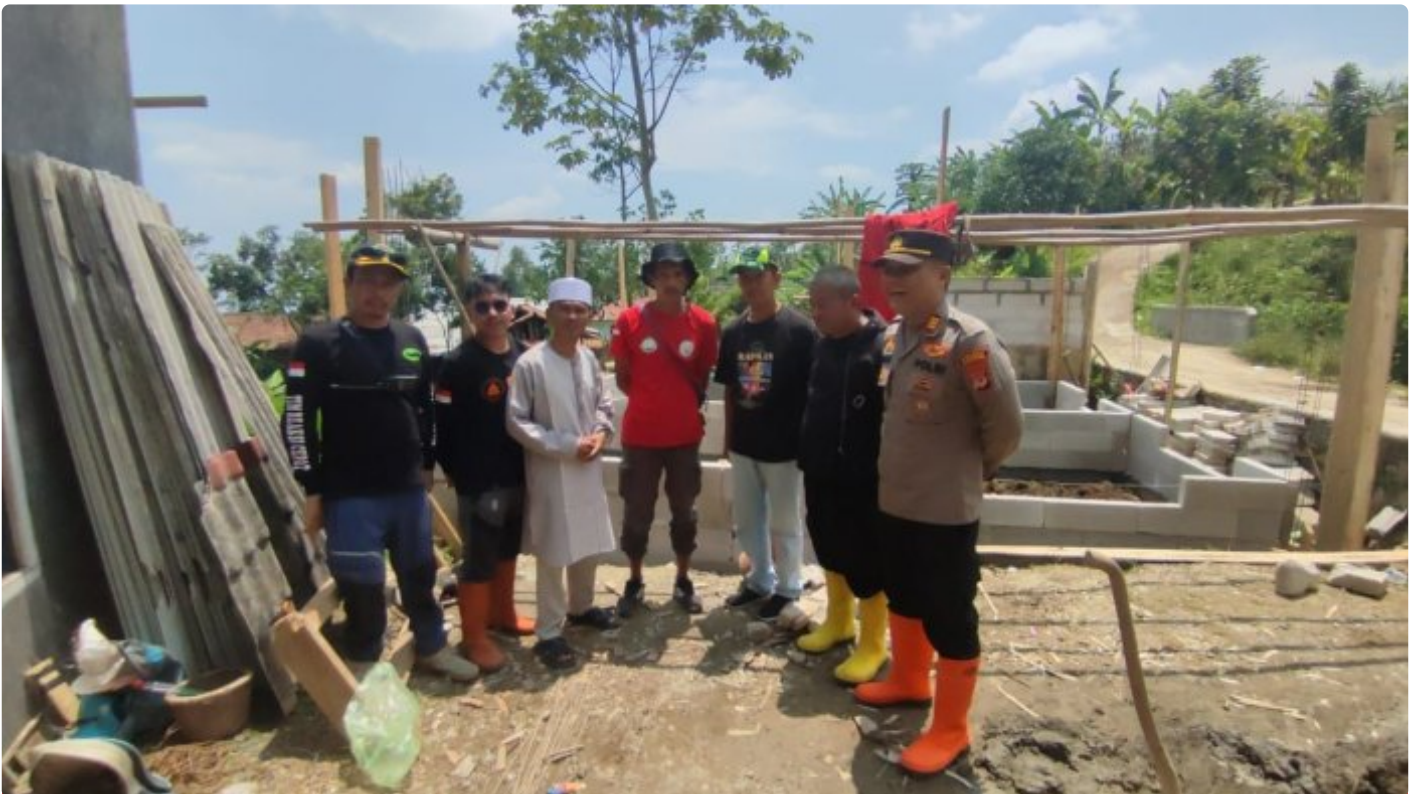
Kapolsek Cidahu Akhmad Suryana Gotong Royong Bersama Warga Perbaiki Rumah yang terkena Bencana Alam
