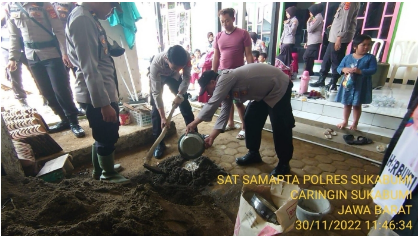
Kapolres Sukabumi Bantu Perbaiki Rumah Warga Yang Rusak Akibat Gempa
