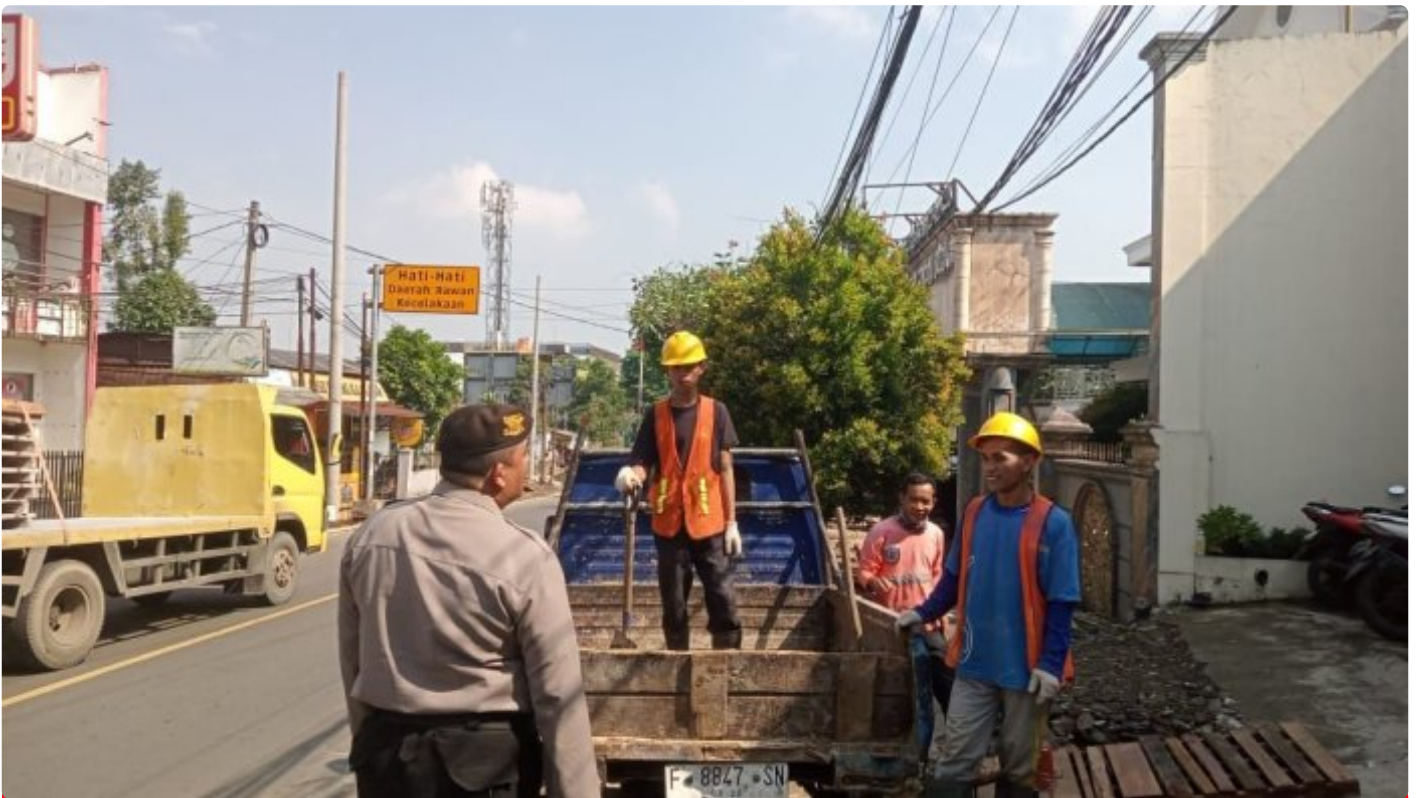
Kanit Samapta Polsek Gunungpuyuh Berikan Himbauan Kepada Pekerja Proyek Trotoar
