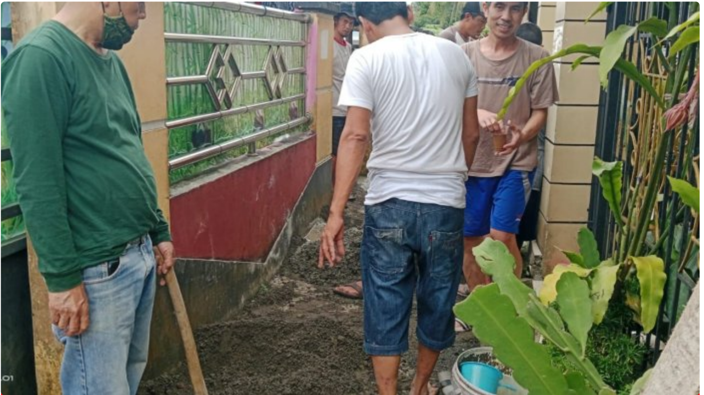
Jalan Gang Dibangun Secara Gotong di Sukabumi Jawa Barat
